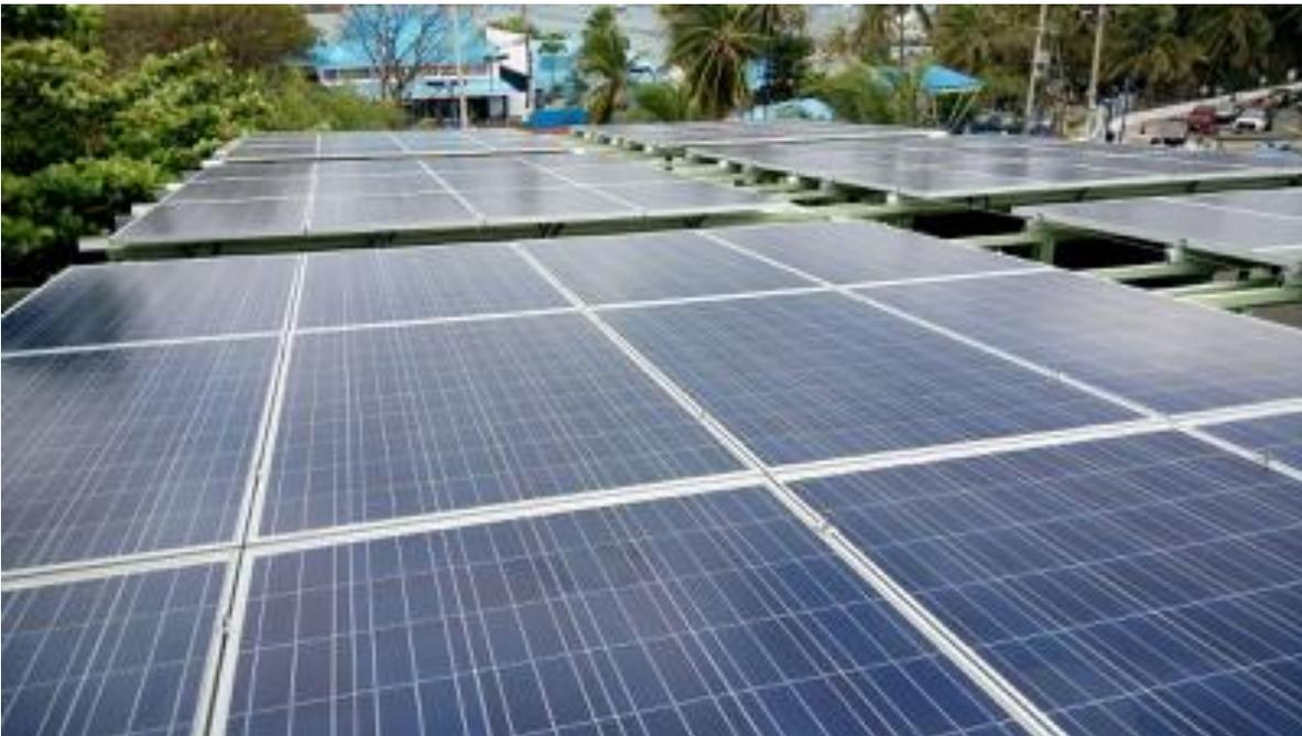
Instalación Fotovoltaica Edificio EEDAS 18 kW (Grid – Tie).
